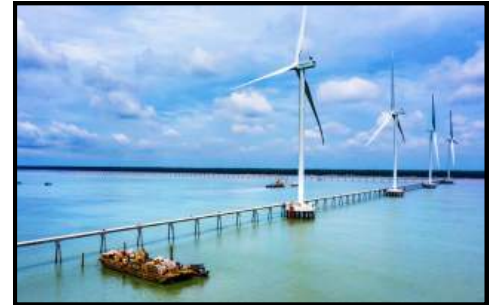
Dự án : Duyên hải-Trà Vinh Hạng mục : Cáp điện hạ thế Du,CVV Đối tác: CT TNHH XD Điện Tấn Phát Năm thực hiện: 6/2023
