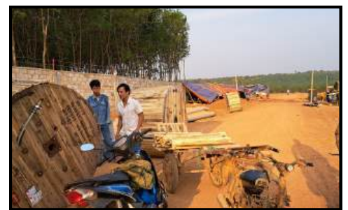
Dự án : Bình Phước Hạng mục : Cáp hạ thế ... Đối tác: Năm thực hiện: 06/2023
