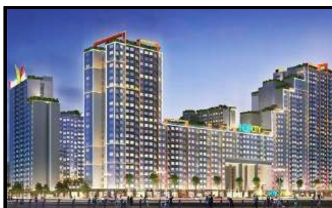
Dự án : New city Thủ Thiêm Hạng mục : thiết bị chiếu sáng tầng hầm Đối tác: Năm thực hiện:
